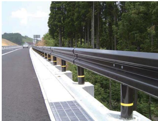
背面に側溝設置の事例
