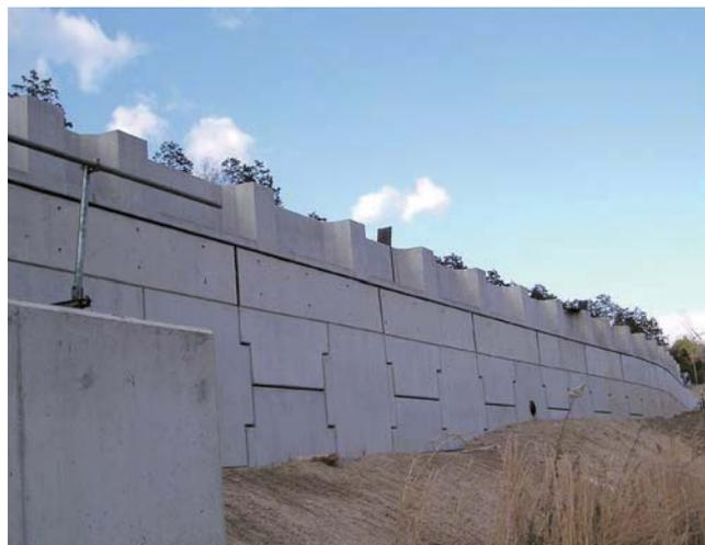
補強土壁直上設置の事例
