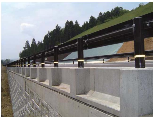
補強土壁直上設置の事例
