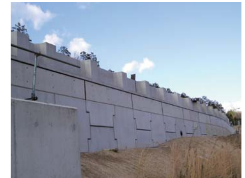
補強土壁直上設置の事例
