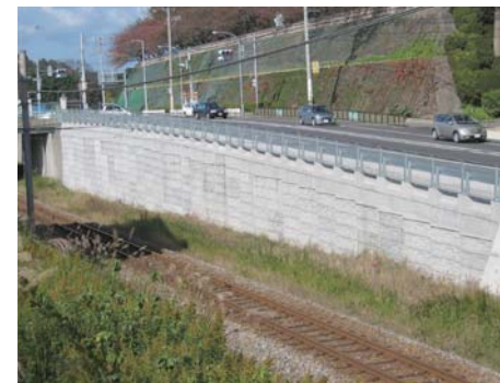
超軽量盛土直上設置の事例
