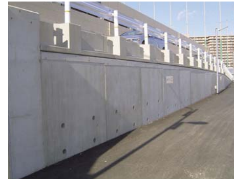
プレキャストL型擁壁直上設置の事例
