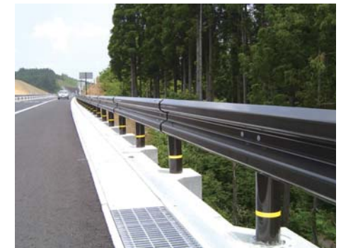
背面に側溝設置の事例
