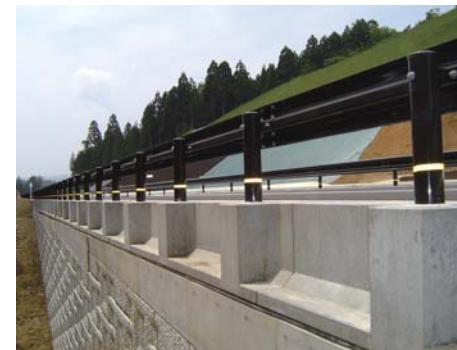
補強土壁直上設置の事例
